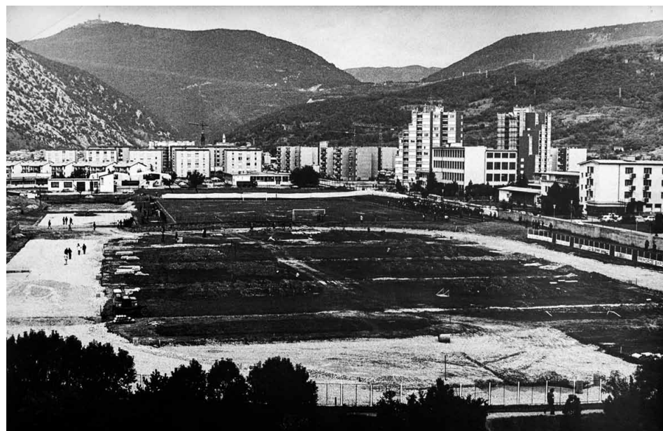
..... Gradnja v teku – 1974. .....
