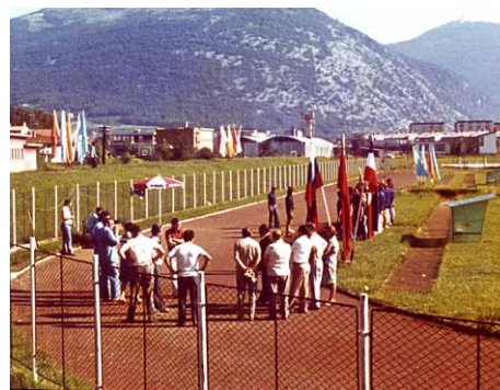
..... Začetek gradnje steze in obnove igrišča – 1974. .....
