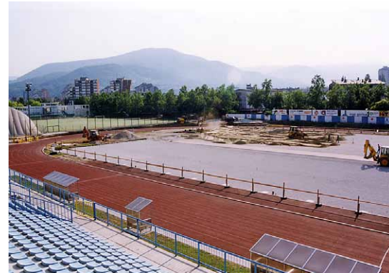
Podlaga za travo na glavnem igrišču – 2000.
