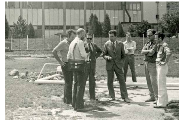
..... Ogled poteka gradnje. .....
